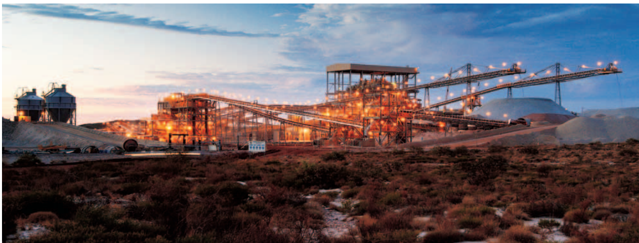
Las recientemente construidas instalaciones de procesamiento de Telfer.
