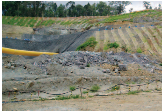
Trabajos de declinación inicial con ventilación en la mina subterránea de Kencana en Indonesia.
