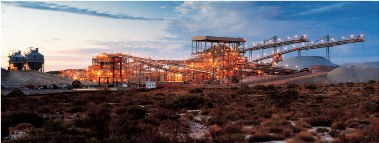
Fasilitas pemrosesan di Telfer yang baru dibuat.
