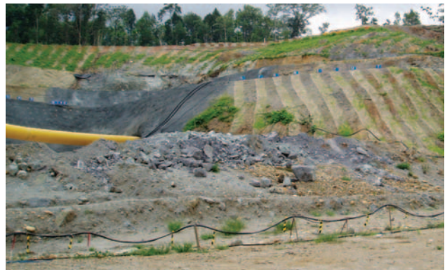
Pekerjaan awal terowongan eksplorasi dengan ventilasi di tambang bawah tanah Kencana di Indonesia.
